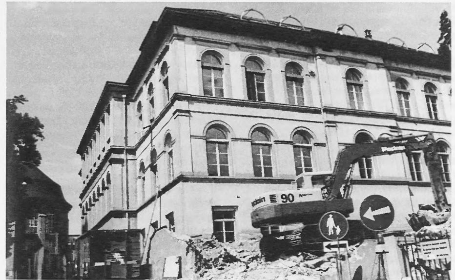
Am 27. Juli wurde mit dem Umbau des ehemaligen Physiologiegebäudes an der Rämistrasse 69 begonnen, der bis im September 1989 beendet werden soll. Das Aeusseres des Gebäudes wird im ursprünglichen Zustand von 1884 rekonstruiert.
